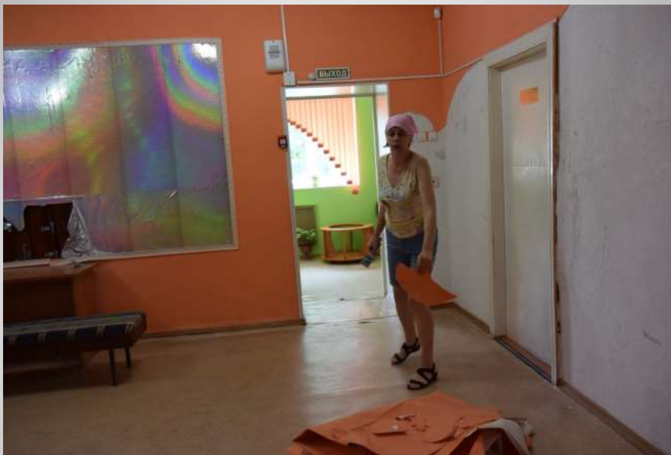
Фойе до ремонта
